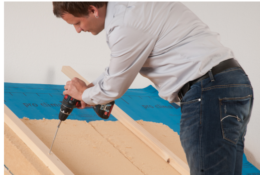
HECO-TOPIX-Therm Exemple de mise en oeuvre
