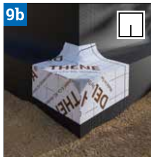
Coins extérieurs avec glaci (Fig. 9a et 9b)
