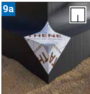
Coins extérieurs avec glaci (Fig. 9a et 9b)
